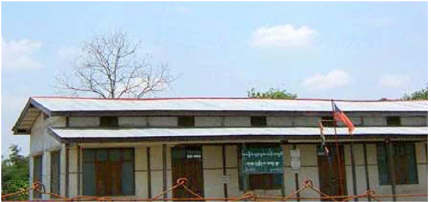
正面側屋根とひさしの部分は同志会義捐金でトタン板を購入し補修
