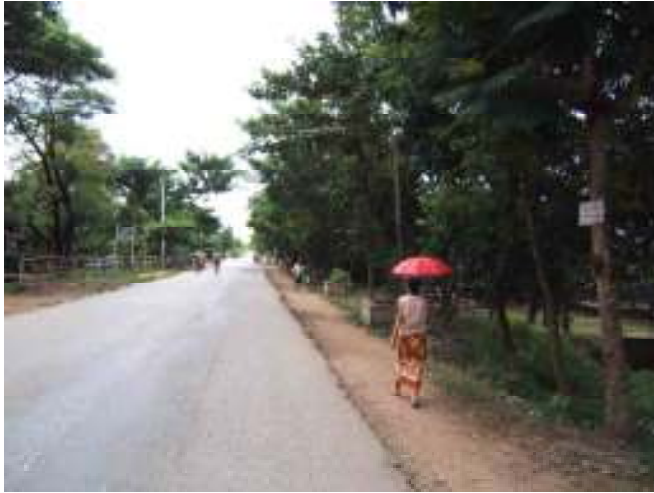
出発時は綺麗な舗装で幅も広い
